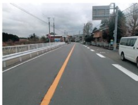
写真 2-1 左 ③ (主) 島田吉田線における施工 7 年後 (H26) の路面状態 右 ⑪ (一) 沼津小山線における施工 5 年後 (H26) の路面状態
