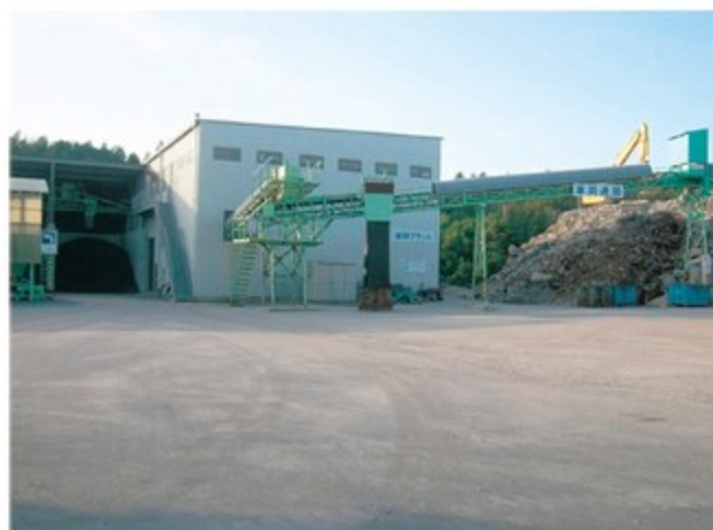
破碎プラント
